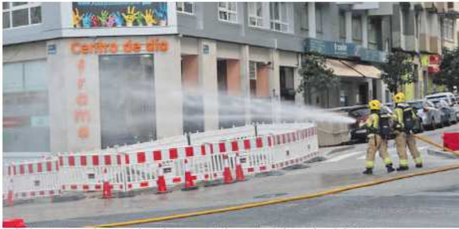
Los bomberos tuvieron que formar una columna de agua para evitar la concentración de gas en la ronda de Outeiro. César Quiñan
