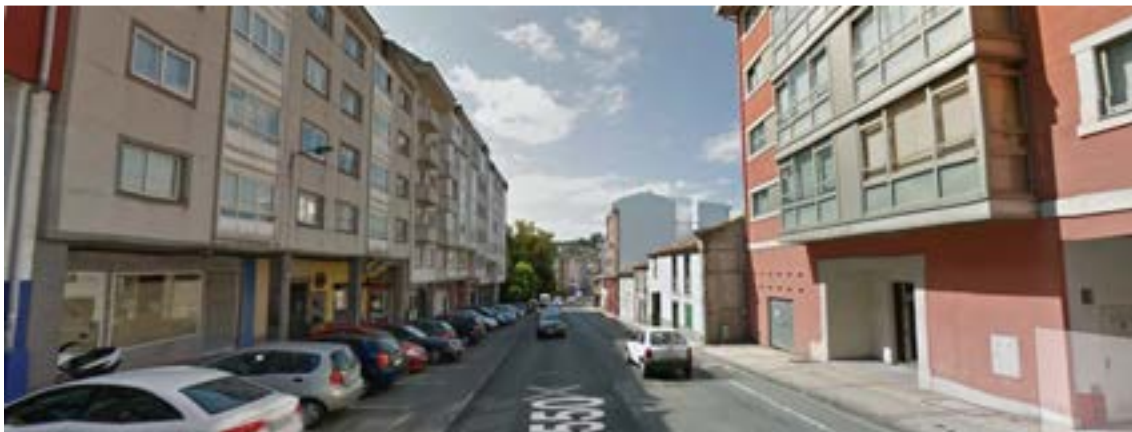
IMAGEN 12: Estado actual de la avenida de Vilaboa, actual N-550.
