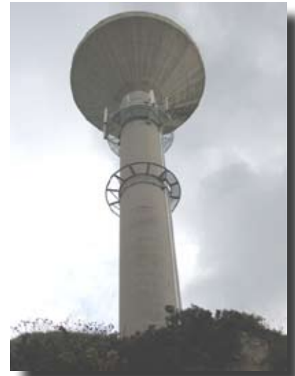
Depósito de agua de Eiris
